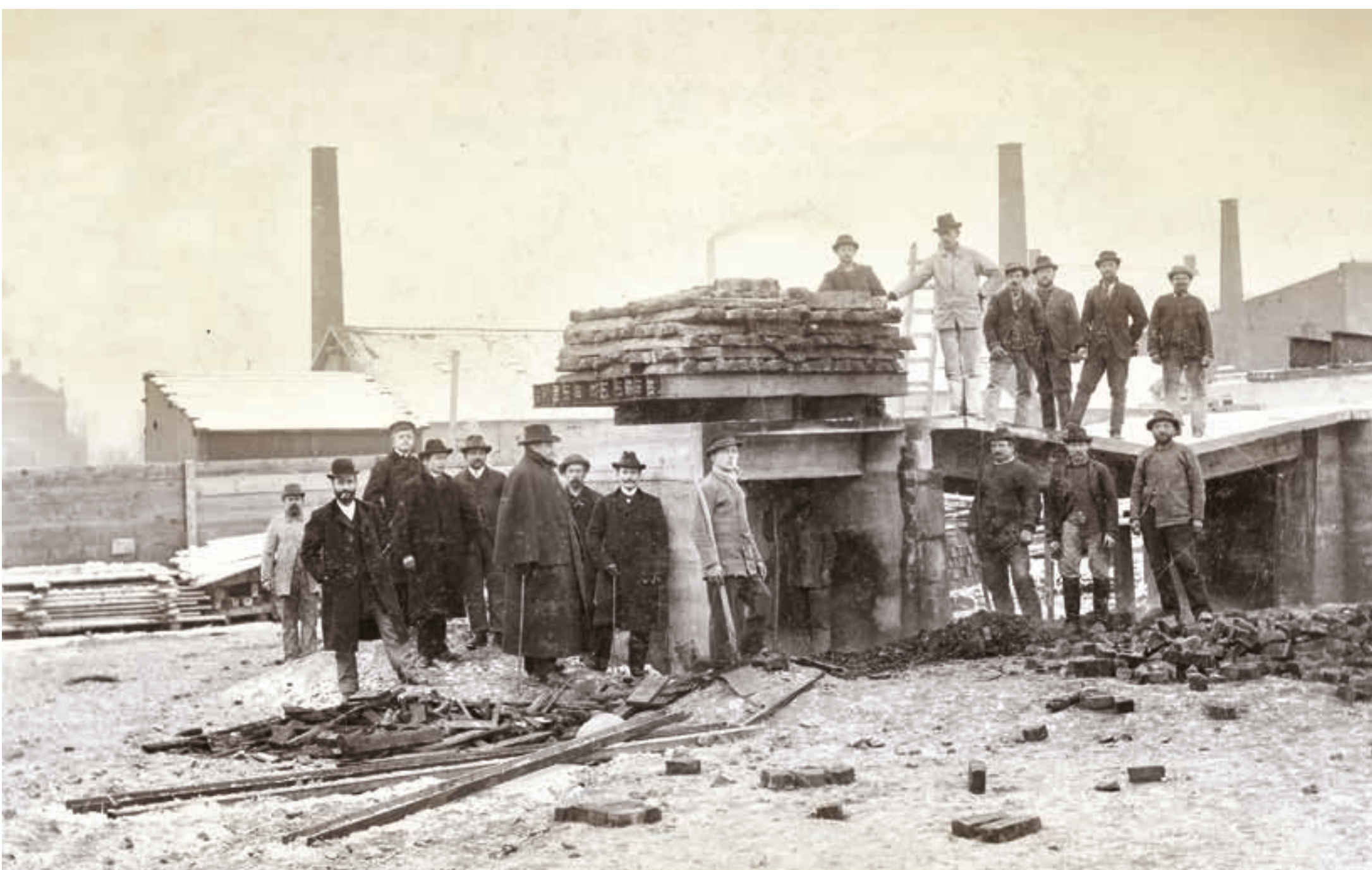
Belastungs- und Brandprobe auf dem Lagerplatz Riebeckstraße am 30./31. Januar 1899 (Cité de l'architecture et du patrimoine, Centre d'archives, Paris)
