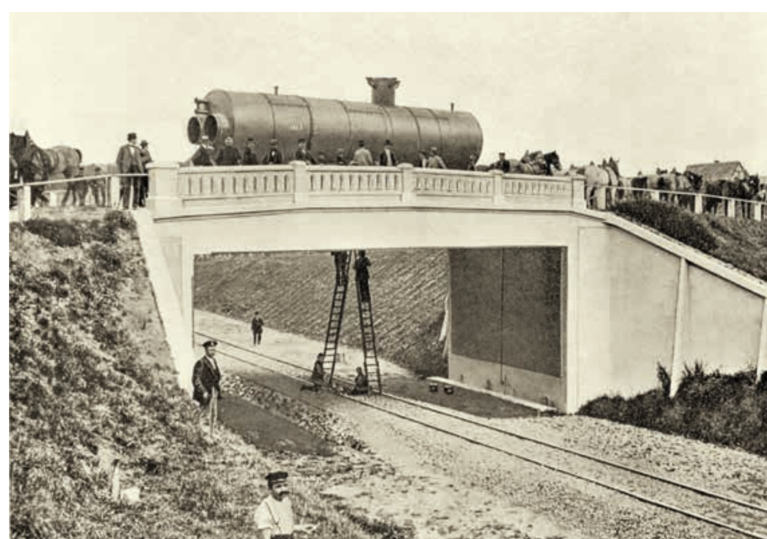
Belastungsprobe der Brücke Markersdorf, 1901 „Nutzlast: Kesselwagen von 30,5 t und 400 kg Menschengedrange“
